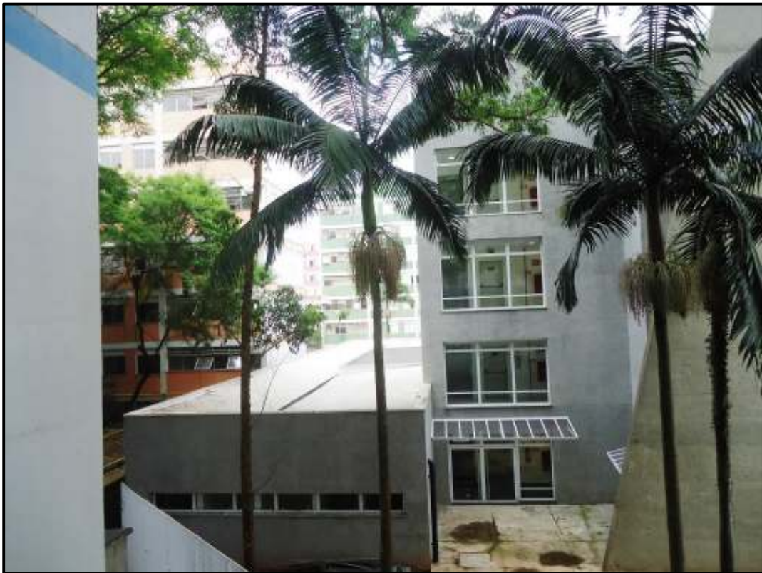
Desfiguramento arquitetônico com construções diversas do modelo construtivo e arquitetônico do projeto original (B)
