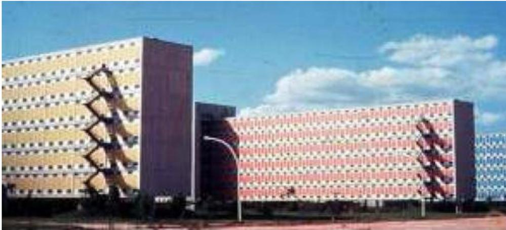
Figura 376: Fachada posterior dos primeiros blocos construídos. Nota-se a escada de emergência e o térreo aberto em pilotis.
